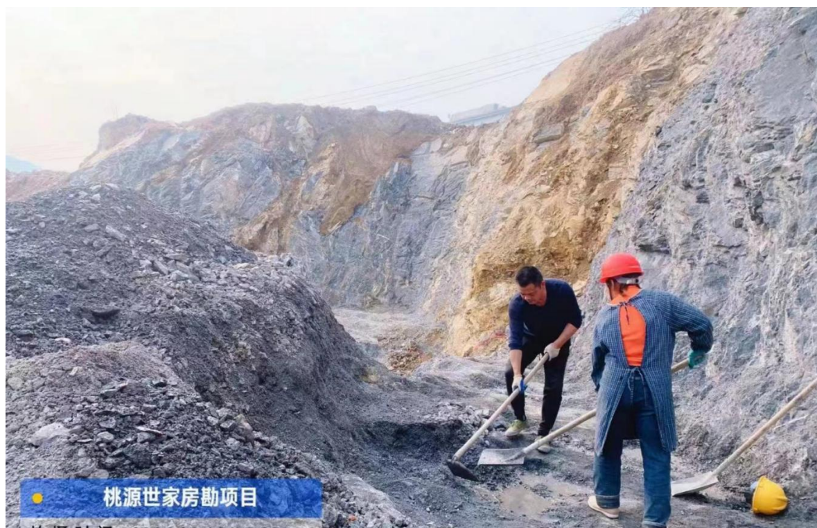
桃源世家房勘项目现场
